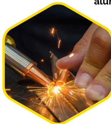
Soldadura en puertas y ventanas
